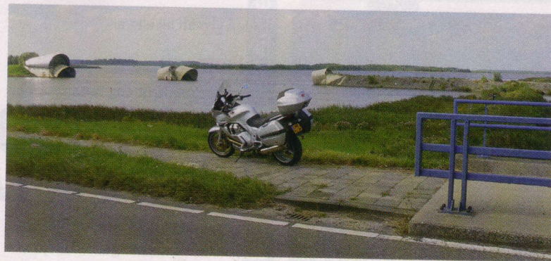
De balgstuw Ramspol bij Kampen behoedt Overijssel voor hoog water uit het IJsselmeer.
